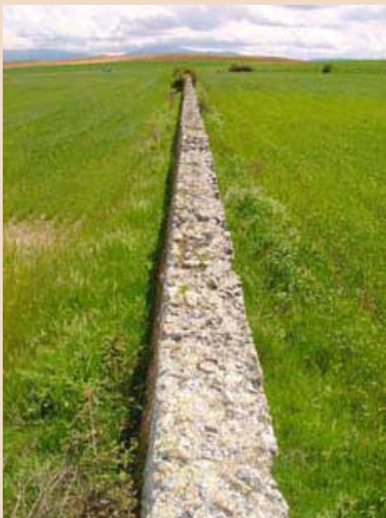
Muro occidental de cierre del edificio de "Las Paredes"
